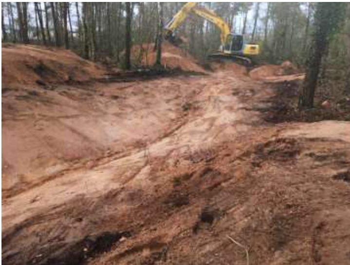
Fig. 9 Herstelwerkzaamheden in het Thusbos langs de Rijksweg.
